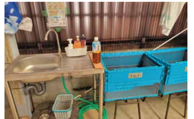
▲新設した手洗い用の水道
