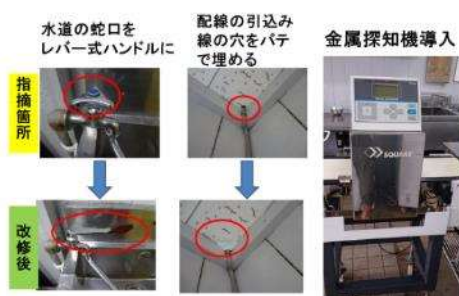
生協の工場検査で指摘部分の改修の一部
